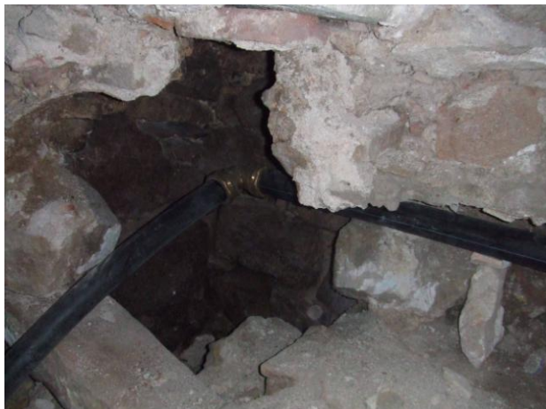
4) Vista detall servei d'aigües desviat. Vista en interior arqueta. Autora: Maria Pujals - ARKPADOC SC
